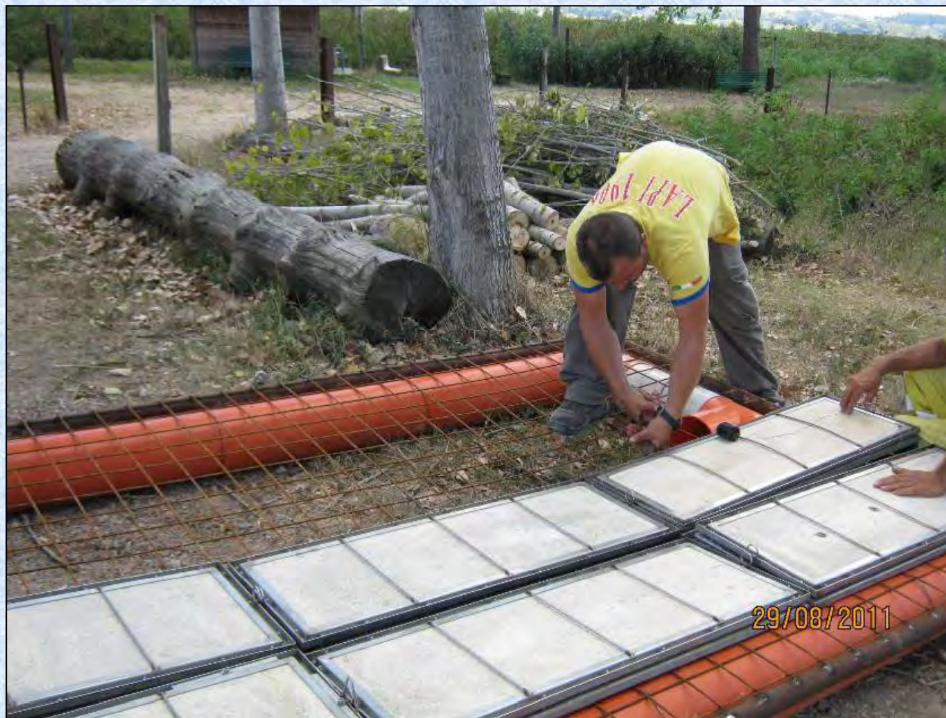
Preparazione piattaforma di ossigenazione
