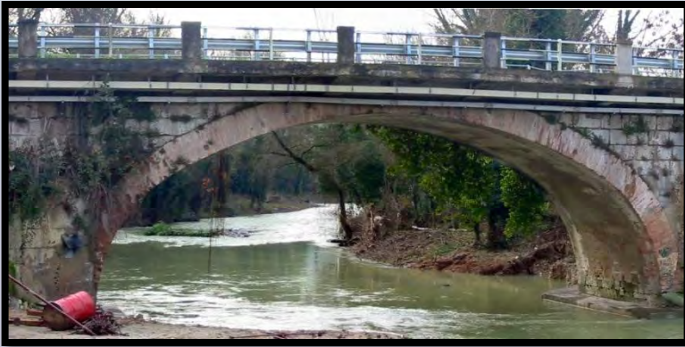
Vecchio ponte S.R. n°71
