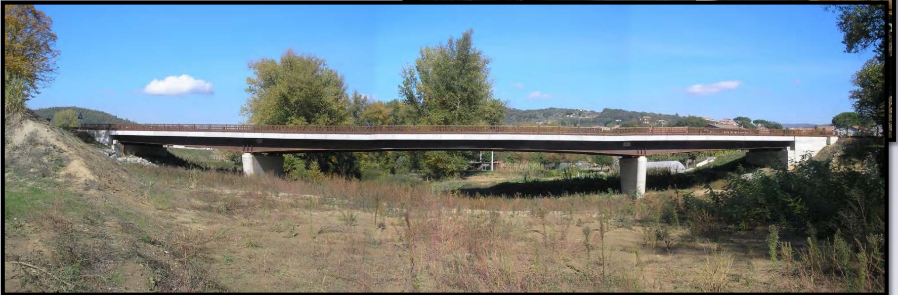
Nuovo ponte S.R. n°71
