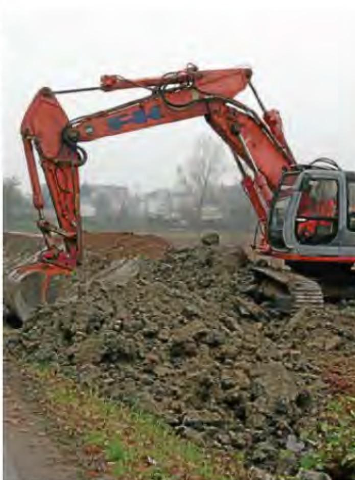
In viale Diaz è già stato realizzato un argine: si attende il bacino
