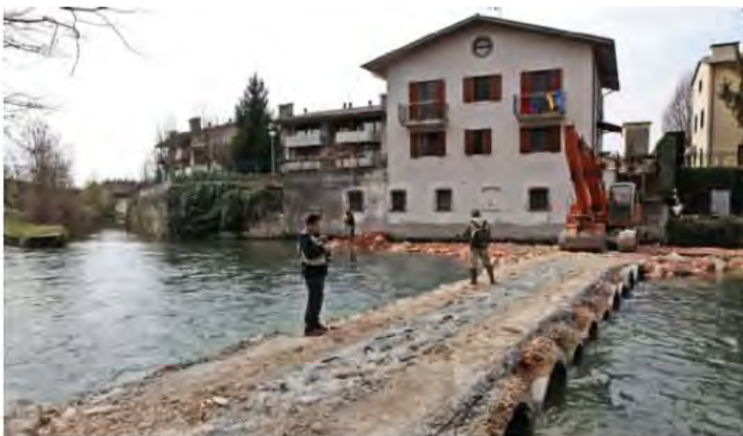
Il ponte provvisorio realizzato sul Fibbio per il passaggio dei mezzi pesanti FOTOSERVIZIO AMATO
