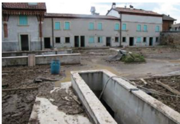
Il piazzale della casa padronale devastato dalla piena
