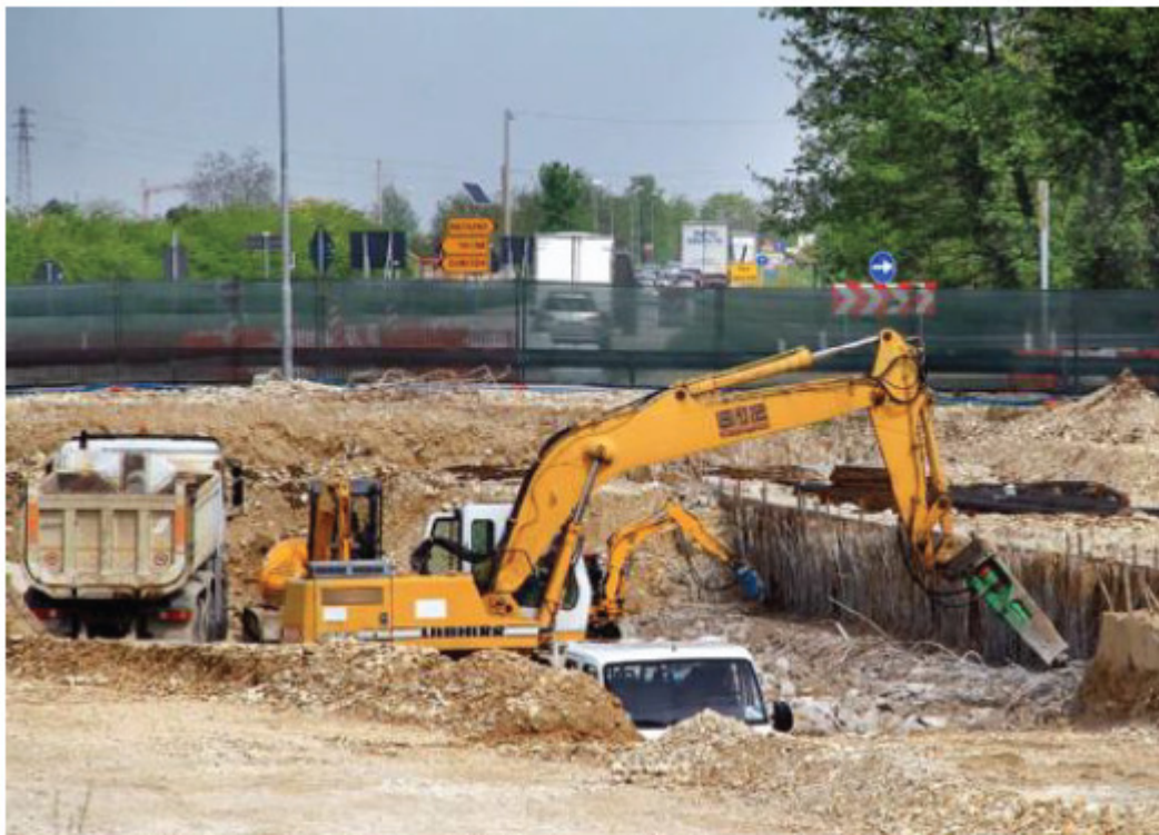
Il cantiere della Pedemontana tra Sarcedo e Montecchio Precalcino. FOTOSTELLA
