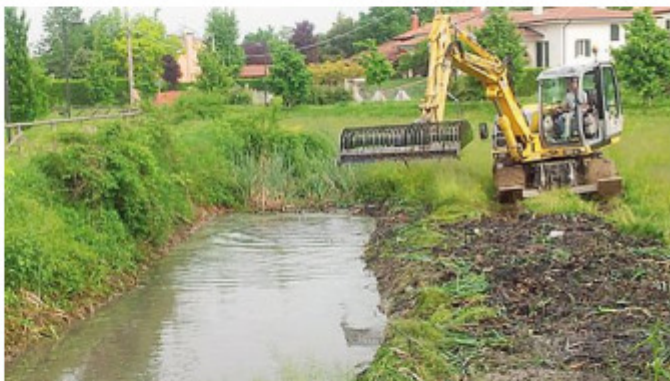
I lavori di pulizia dello scolo di Selvazzano
