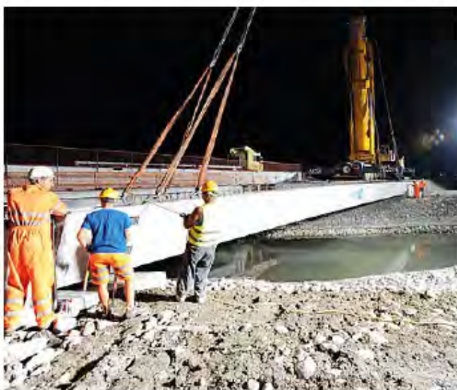
Un cantiere notturno per la terza corsia sull'A4
