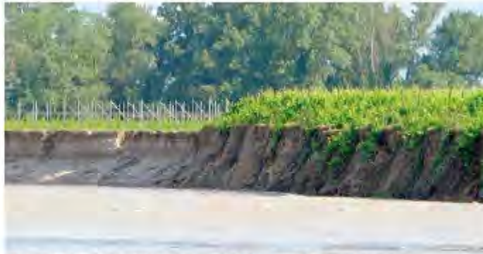
Il visibile risultato dell'erosione del Piave nel tratto dell'orto
