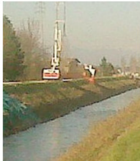
Iniezioni di cemento negli argini
