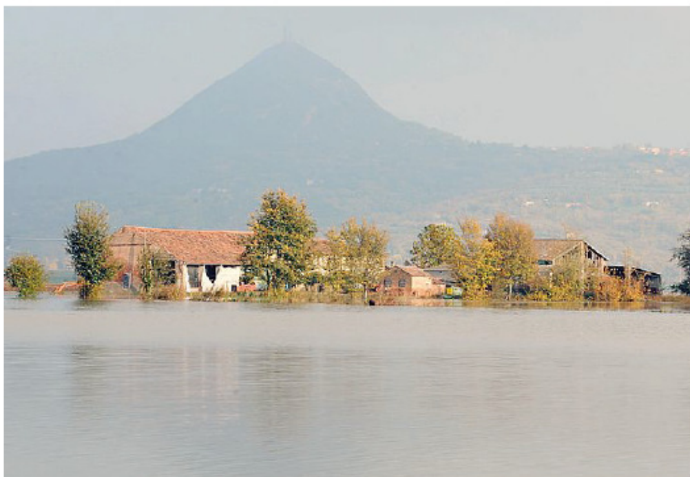
Gli effetti dell'alluvione del 2010 nell'Estense. Nel 1995 gli allagamenti furono causati anche dall'imperizia dei tecnici
