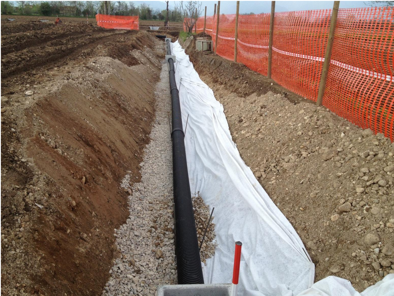
8 - Sistema di infiltrazione sotterranea con tubazioni forate – Tezze sul Brenta – 2013 – 0,498 ettari
