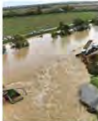
Argine rotto nell'alluvione 2010
