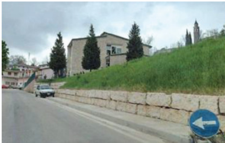
Al via la bonifica della frana a San Luca
