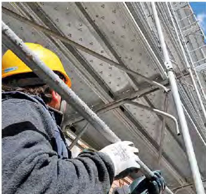
Un cantiere edile: è polemica sul Piano casa della Regione
