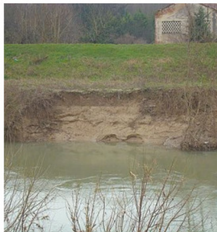
Il cedimento sull'argine dopo il ponte
