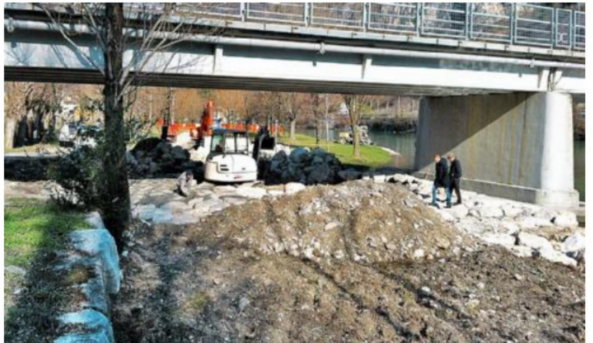
Il cantiere aperto lungo la riva del Brenta a Campolongo
