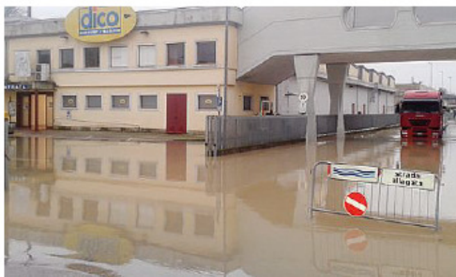
Allagamento nella zona produttiva di Rubano
