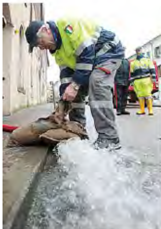
Una pompa idrovora in azione
