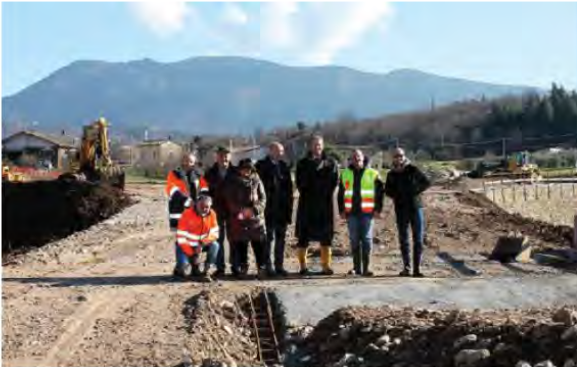
Sopralluogo dell'assessore Carla De Beni al cantiere della Circonvallazione Sud
