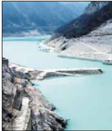
COMPLETATA la diga di Ravedis
