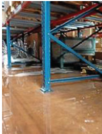
Un magazzino allagato. A.C.
