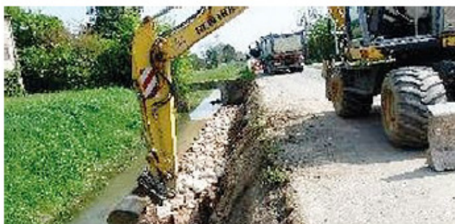
Sono iniziati da una settimana i lavori nella fossa Storta lungo via Pelosa
