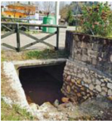
Il rio dopo i lavori di pulizia. MA.CA.
