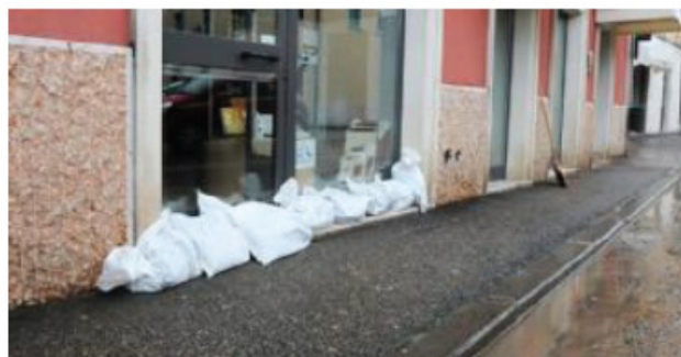
L'alluvione di un anno fa aveva causato danni anche seri
