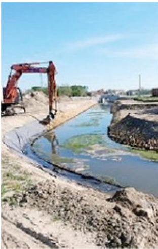
Lavori alla rete di bonifica
