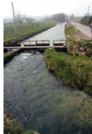
Opere di bonifica su un corso d'acqua in Veneto
