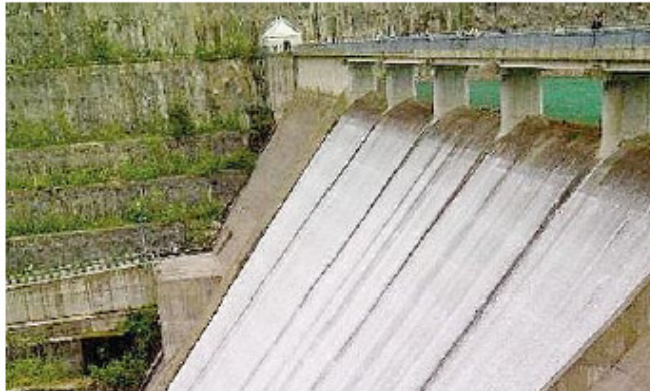
La diga di Ravedis che ha messo in sicurezza l'Oplitergino-Mottense
