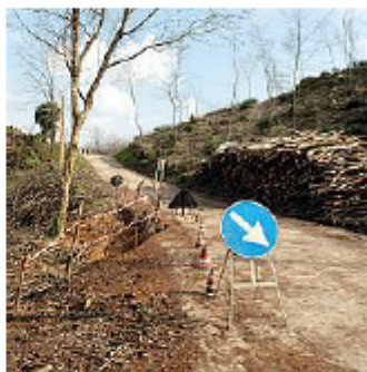
La frana di via Monte Nero
