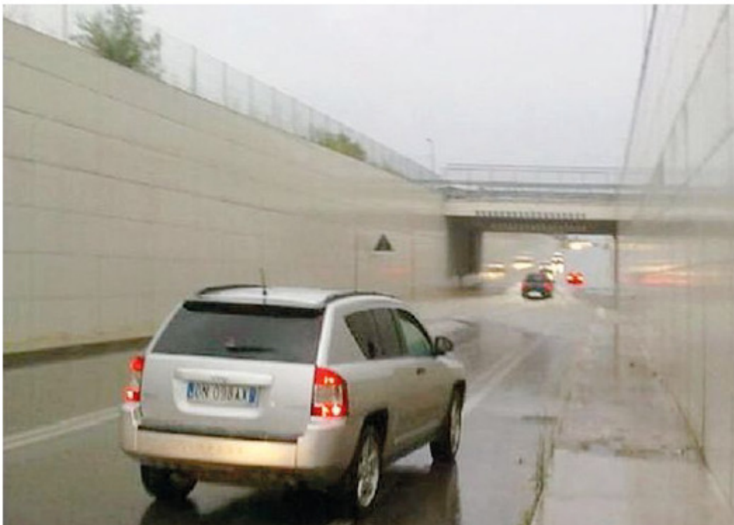
Il sottopasso della bretella Boston ieri pomeriggio si è di nuovo allagato ed è stato chiuso per un'ora
