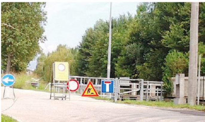
La strada bloccata per essere messa in sicurezza dopo la frana
