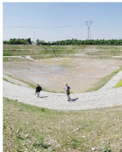
Bacino d'espansione a Fonte di Riese
