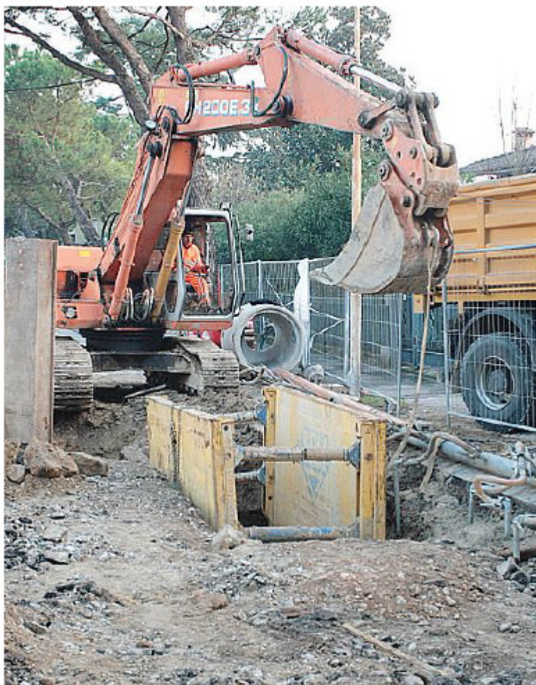
Lavori sulla fognatura in via Scapacchiò a Selvazzano
