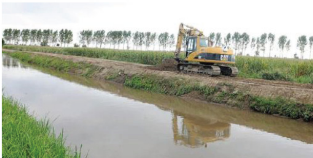
Un mezzo del Consorzio al lavoro: pulizia e manutenzione dei canali sono opere principali DIENNE FOTO
