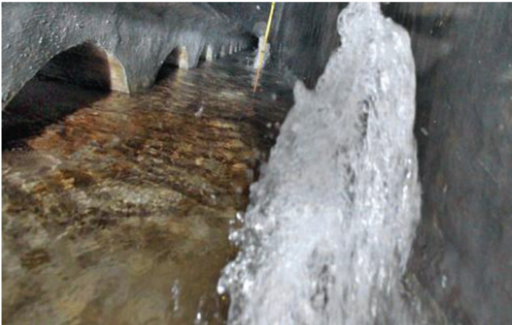
Il mattino esperti e amministratori a confronto per cercare di arginare il fenomeno degli allagamenti
