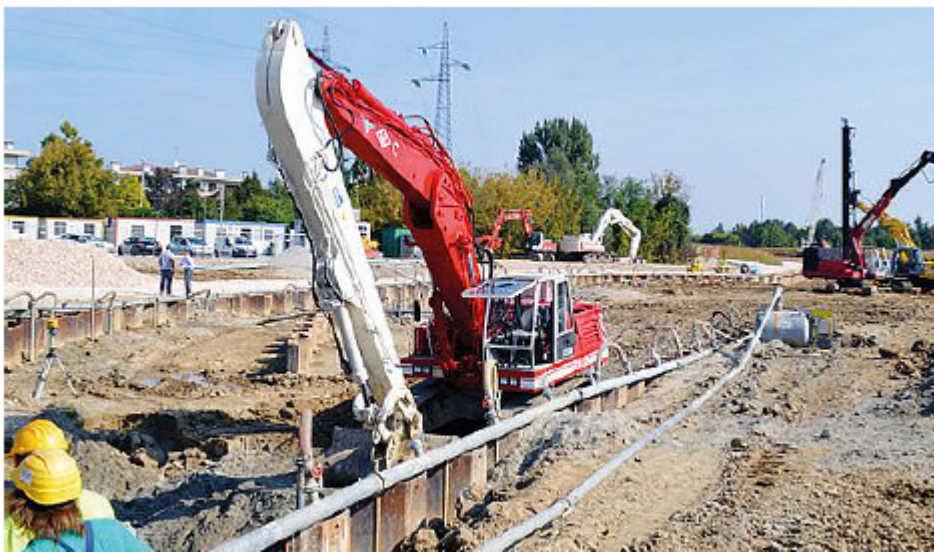
Il cantiere e gli scavi dove sorgerà il canale scolmatore che bloccherà gli allagamenti
