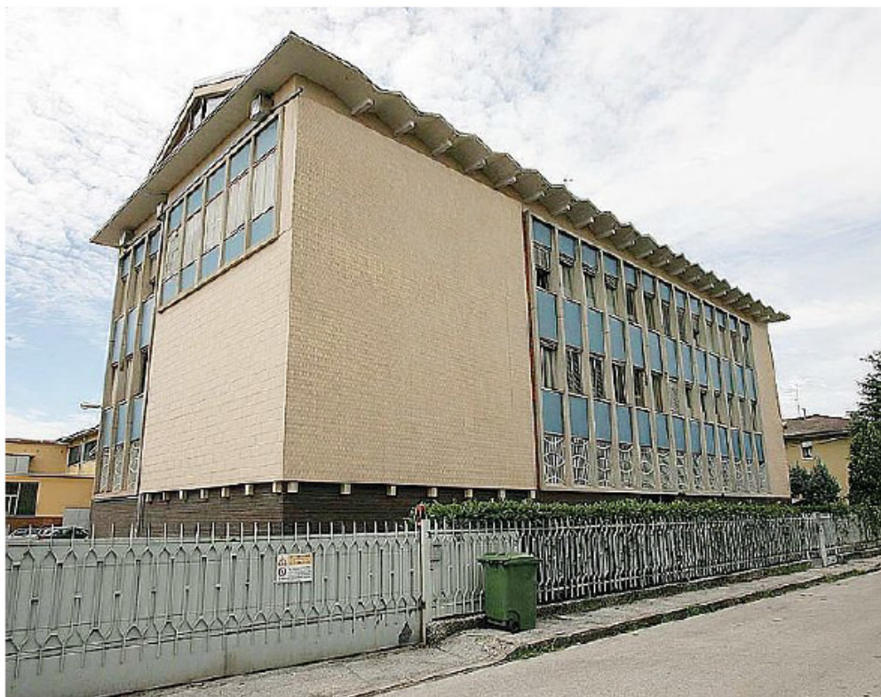
Lo stabile delle ex Argenterie Greggio a Tencarola: si avvicina l'ora della bonifica per l'area produttiva
