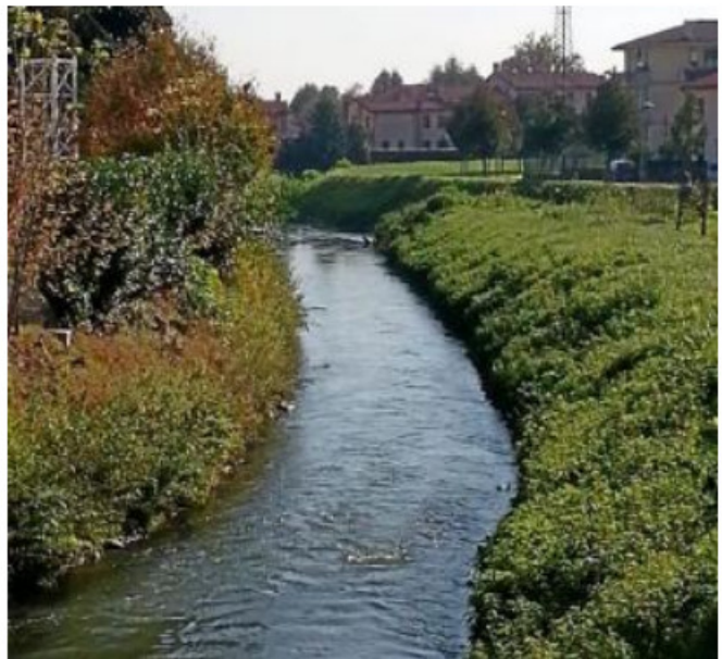
L'intervento del Comune riguarda gli argini del rio Tesinella. GOBBO
