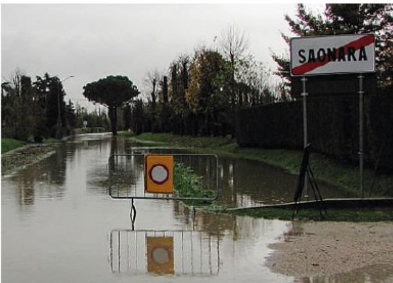
Immagini delle strade allagate dalla pioggia di ieri a Saonara
