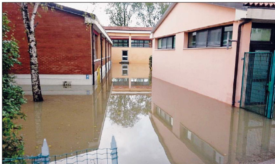
Sotto acqua Una delle strutture Ulss fatte evacuare in seguito agli allagamenti
