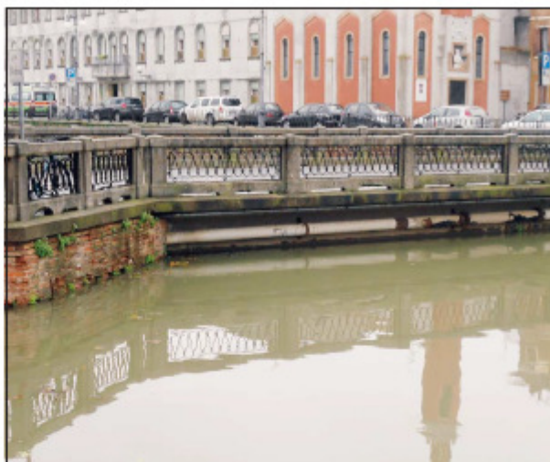
In senso orario: il Canalbianco lambisce ponte Sant'Andrea e minaccia il centro; via Spolverin, l'altra sera, trasformata in un vero e proprio canale; il fosso in zona Coop intasato dalla vegetazione
