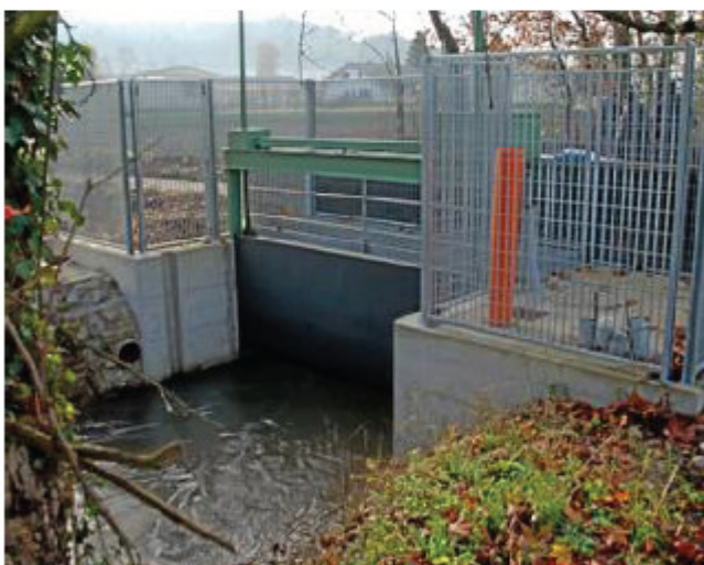
La paratoia sul Tione realizzata vicino a casa Vittoria
