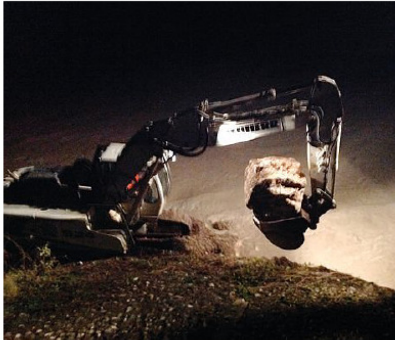
Le enormi rocce scaricate nel fiume per deviarne il corso
