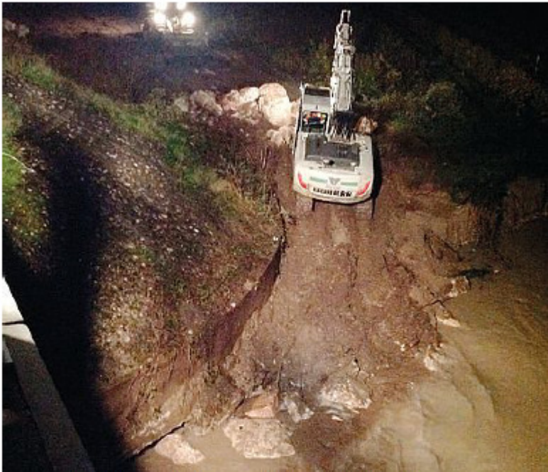
Le operazioni di messa in sicurezza del ponte di Cimadolmo
