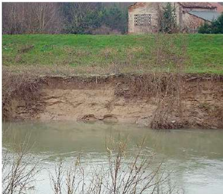
Un cedimento dell'argine del Bacchiglione scoperto negli ultimi mesi
