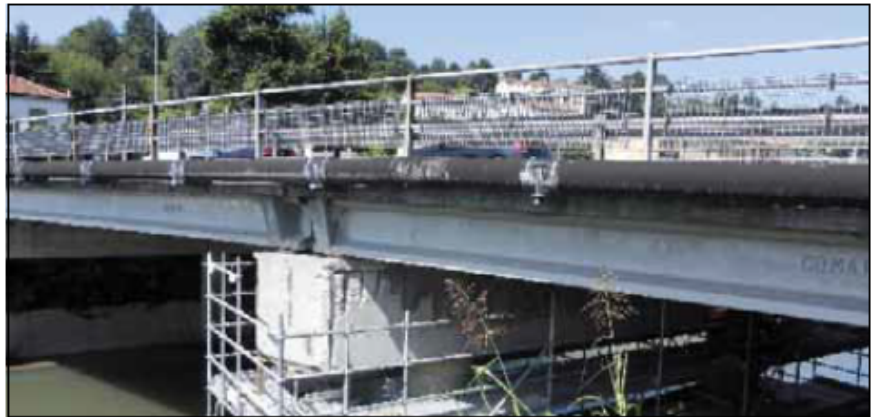
RIQUALIFICAZIONE Fra i lavori conclusi anche il ponte dello Stadio sul Bacchiglione
