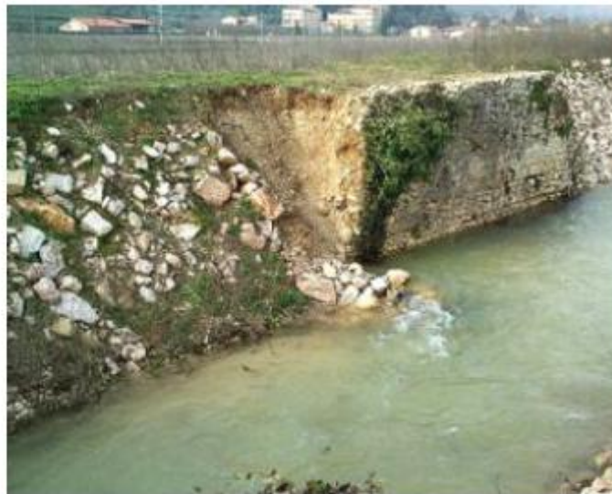
Un muro di contenimento della Prognella in evidente degrado
