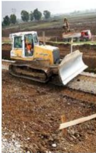
Un dozer al lavoro. STELLA
