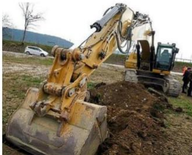
La ruspa con cui Zaia ha dato il primo colpo di pala per i lavori
