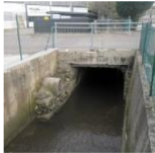
Il ponte a rischio esondazioni. M.G.
