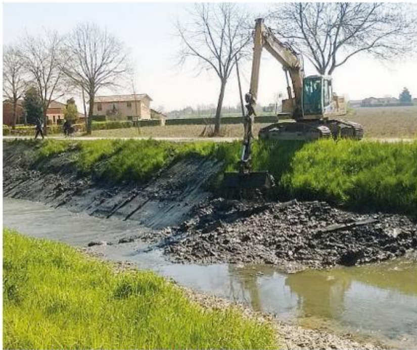
I lavori di scavo in corso nel bacino del Fiumicello
