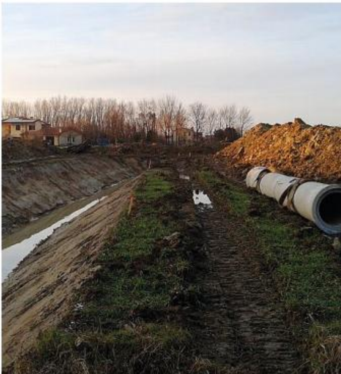
I lavori di ricalibratura della canaletta Veronese a Tavo di Vigodarzere
