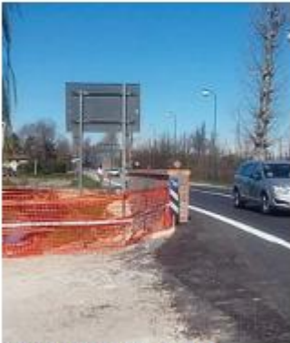
Il ponte lungo il Terraglio
