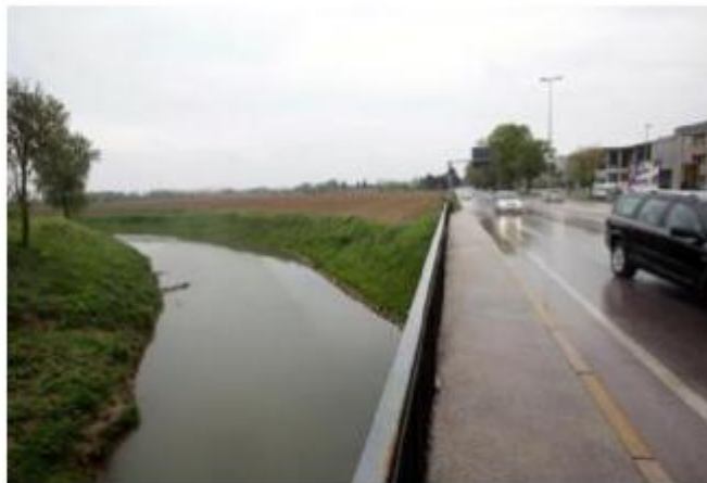
L'area dove sorgerà il bacino contro le alluvioni del Bacchiglione
