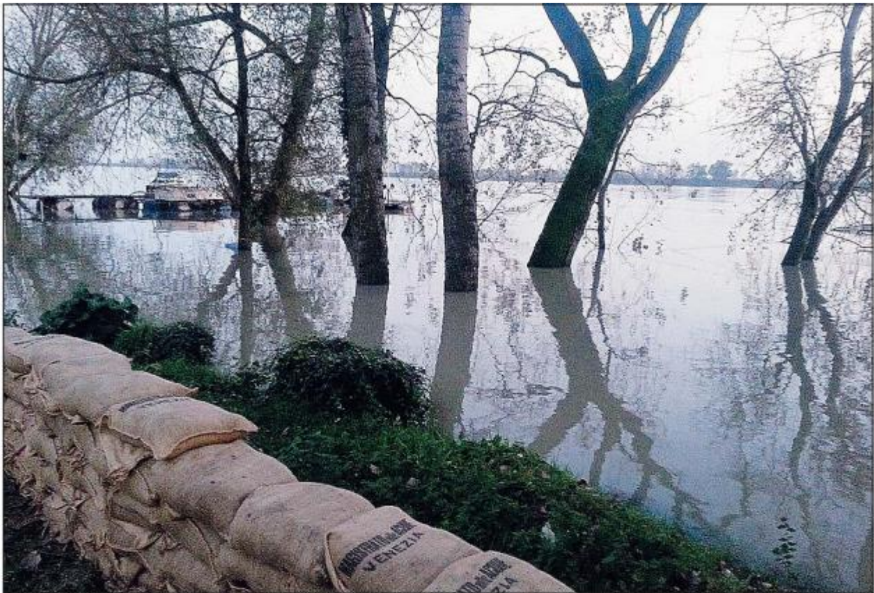
Interventi di consolidamento anche lungo gli argini del Po
