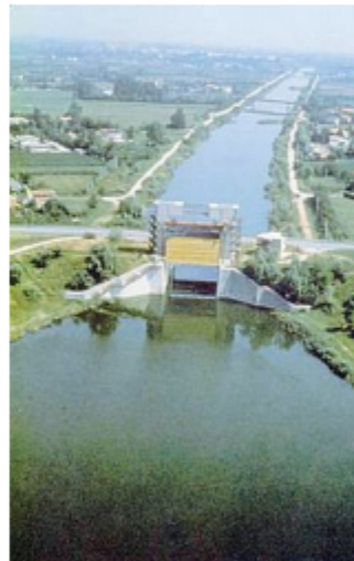
Un tratto dell'idrovia
